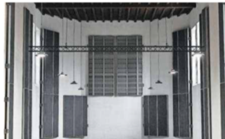
Mittels Akustikkläden lässt sich der Raumklang anpassen.
